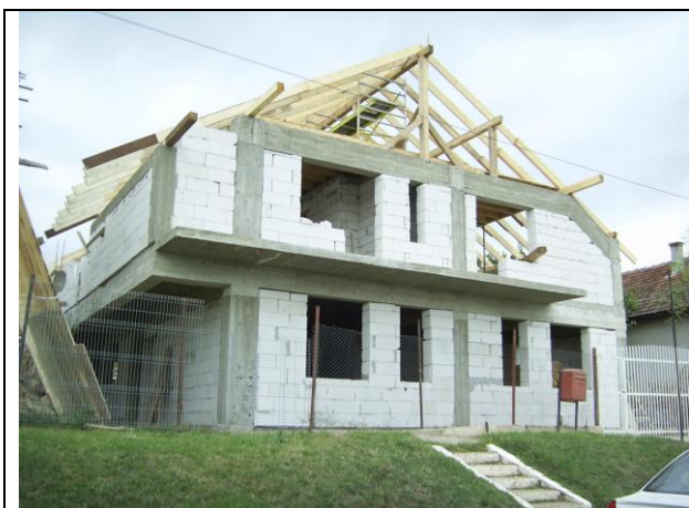
Het project Bencec in aanbouw
